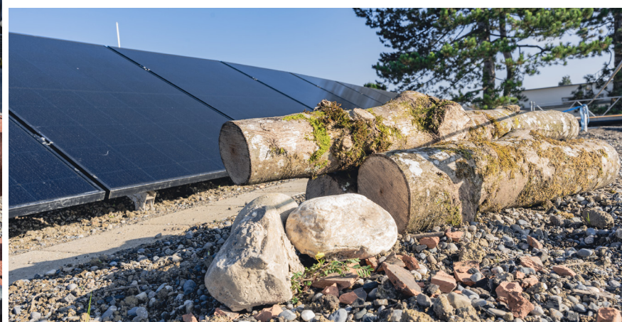
Das aus den Ziegeln neu gewonnene Material wird als Dachsubstrat wiederverwendet und bildet zusammen mit der Pflanzenkohle die Basis für die zukünftige Dachbegrünung.
