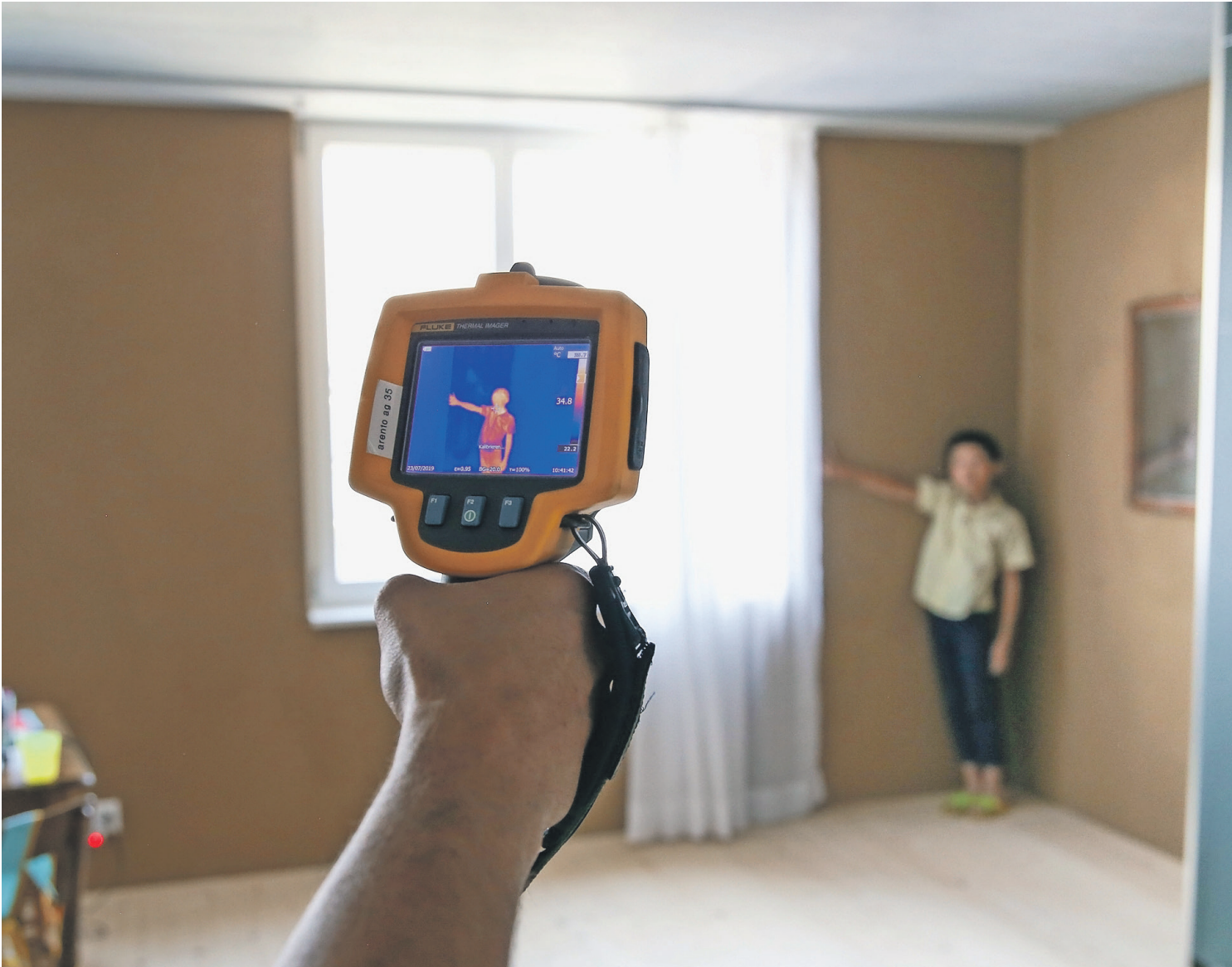
Kontrolle mit der Wärmebildkamera: Sie zeigt an, wie stark die ockerfarbene Lehmwand in der Wohnung kühlt. Fotos: Nathalie Guinand
