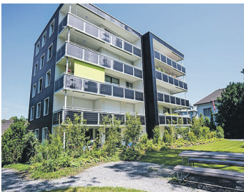
Die Fassade des Sonnenparks Plus ist voller Solarpannels.
