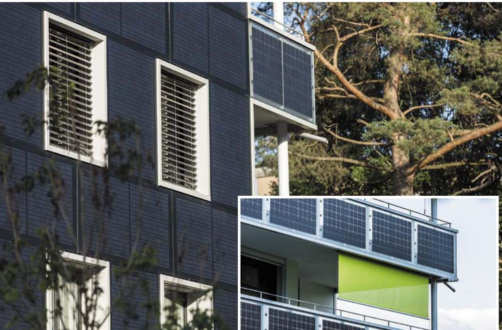
Die klassische Aufdachanlage reicht nicht aus, um den Energiebedarf der Bewohner zu decken. Daher werden zur Stromerzeugung auch die Fassaden sowie die Balkone genutzt.
