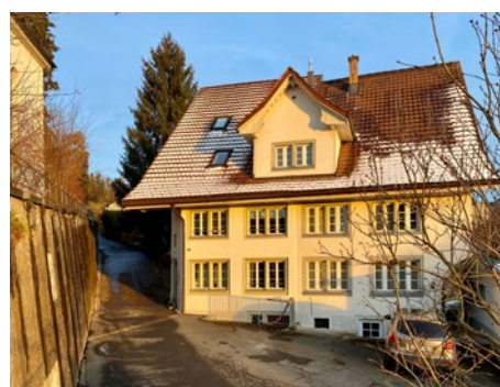
Die Linke Haushälfte ist mit 30 mm Aerogel gedämmt
