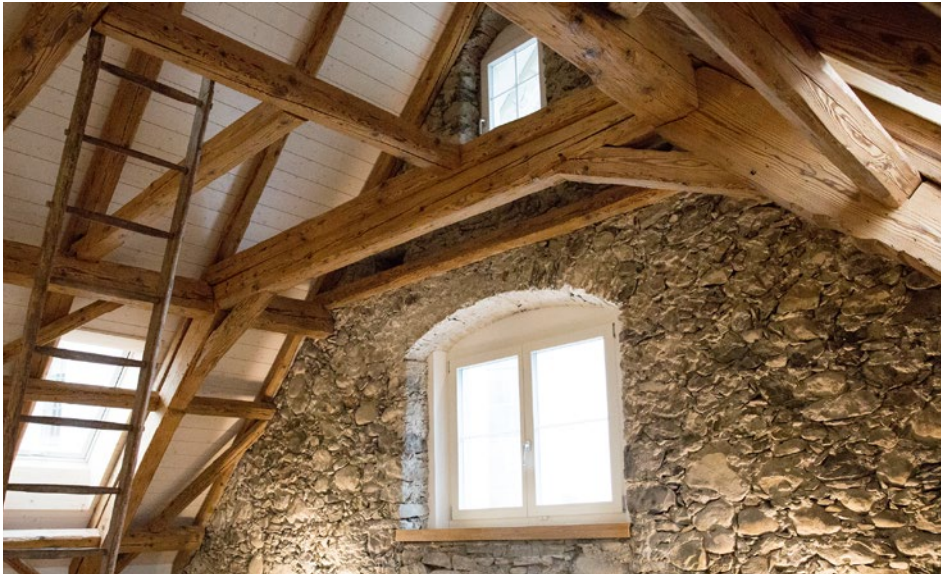
Warme Bollensteinmauer innen dank 30 mm Aerogeldämmung
